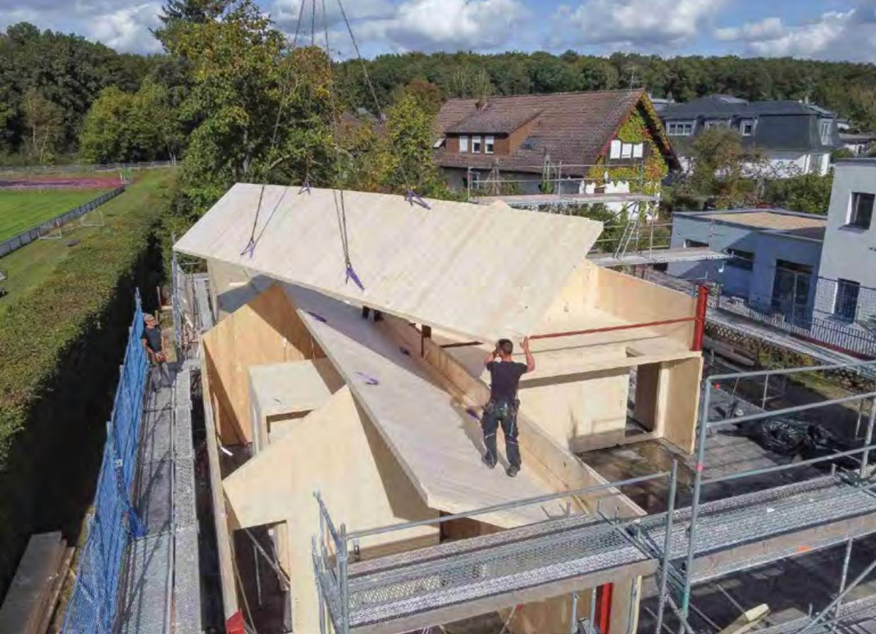
Montage der CLT-Wände und -Deckenteile
