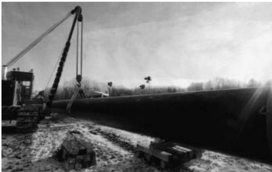
Rohre des Anstoßes: Verlegung von Gazproms Ostsee-Erdgas-Pipelines. – Foto: Newsweek
