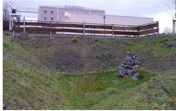
Versickerungsbecken auf Firmengelände (Raenman, CC BY 3.0)
