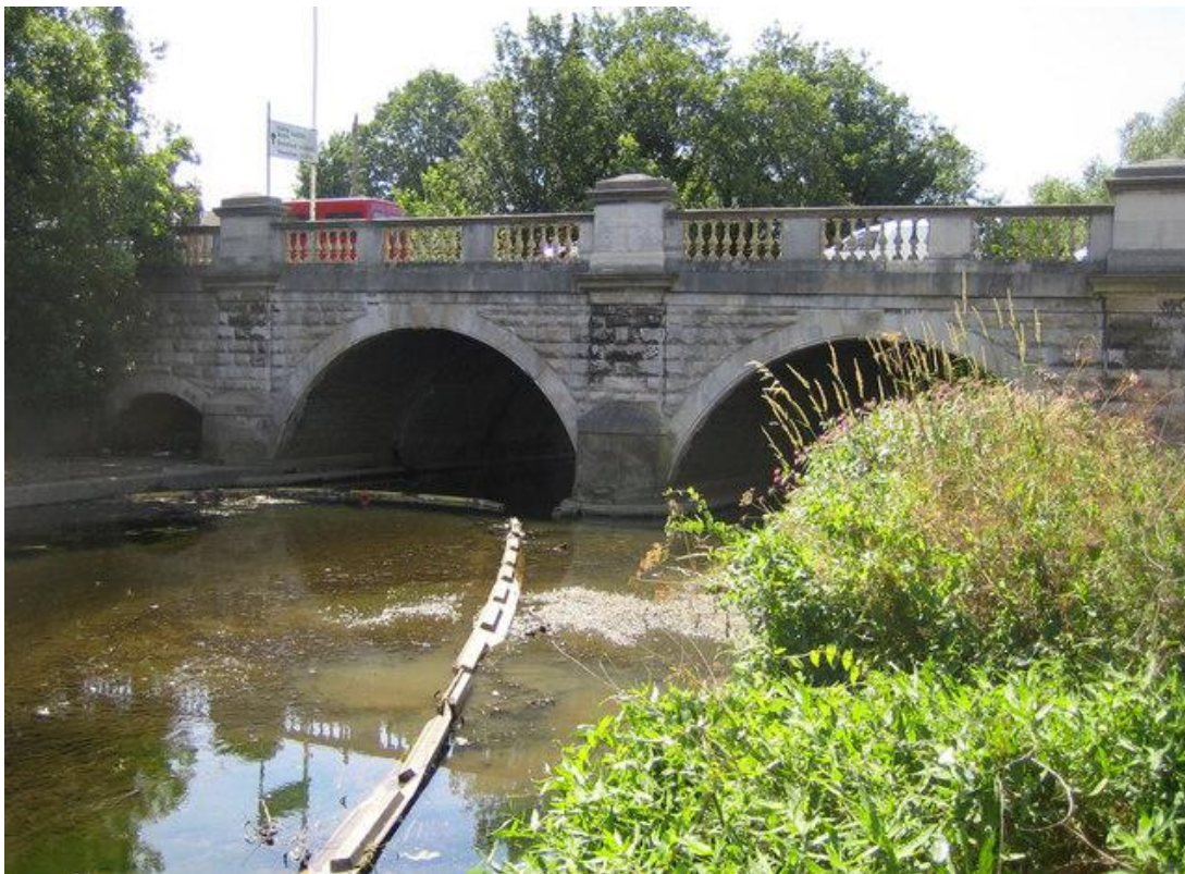
Abbildung 2: Schwimmende Müllbarriere an der Hanwell Bridge im Fluss Brent, Großbritannien. Foto von Nigel Cox, CC BY-SA 2.0, Quelle: Wikimedia Commons 31
